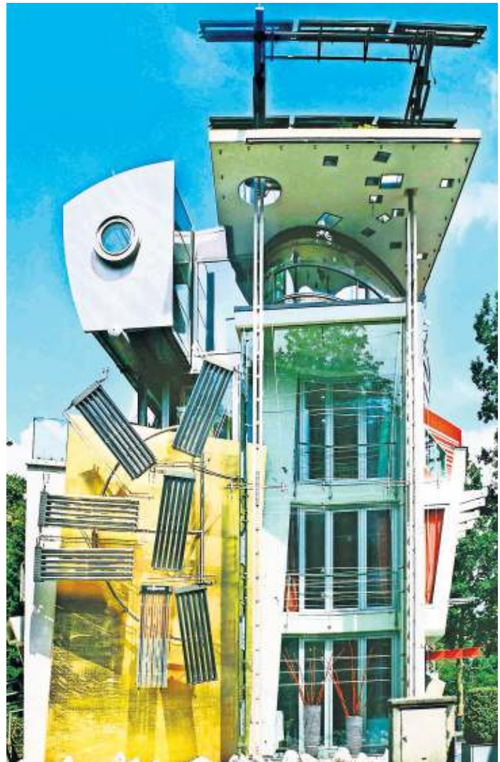
Extravagante Fassade: die Villa Elbchaussee 96 in Hamburg
